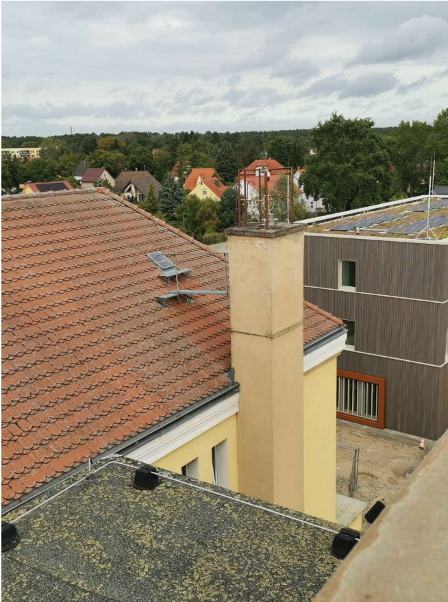
Aufsicht auf Schornstein Saaltrakt - Ostseite
