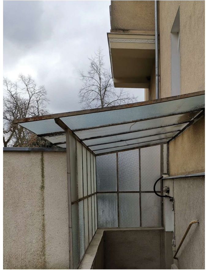
Kellerabgang Giebel Ost
