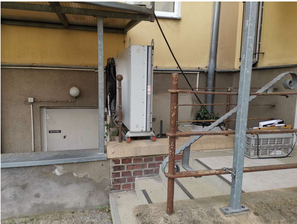
Zugang Hofseite - Überdachungen und Kühlgeräte
