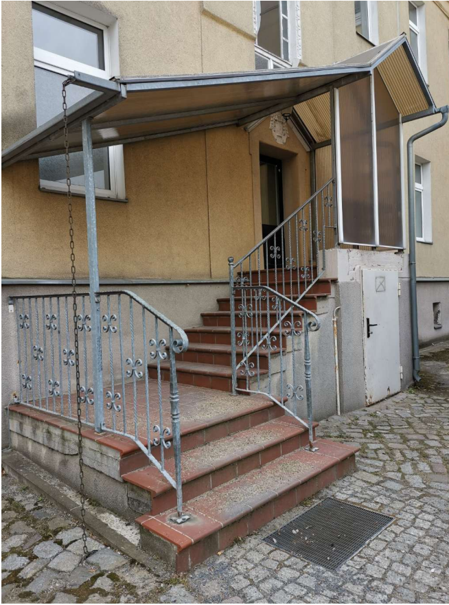
Treppe mit Überdachung Ostflügel Hof
