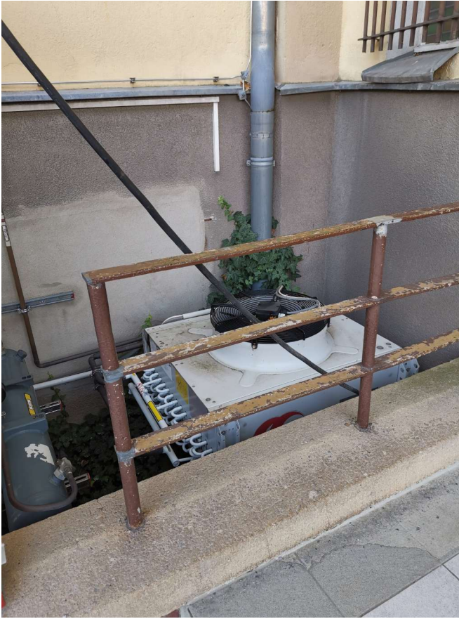
Hofzugang Westflügel mit Vordächern (Erneuerung bzw. Abbruch vorgesehen)
