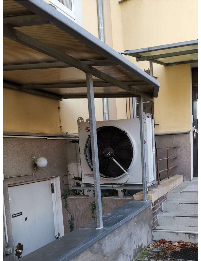
Überdachung und Klimageräte Saaltrakt West
